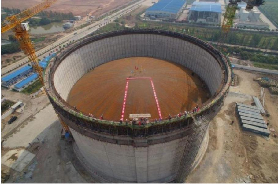
↑2018年4月9日，低温储罐气顶升圆满成功，低温储罐气顶升是巨正源丙烷脱氢制高性能聚丙烯项目一期工程建设的重要节点，标志着一期工程建设即将全面进入设备安装阶段。
