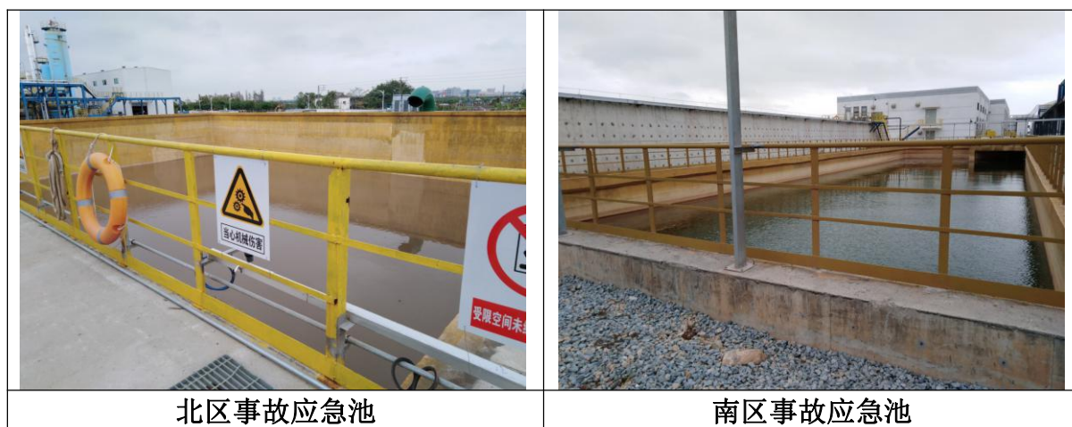
图 4.2-1 事故应急池照片
