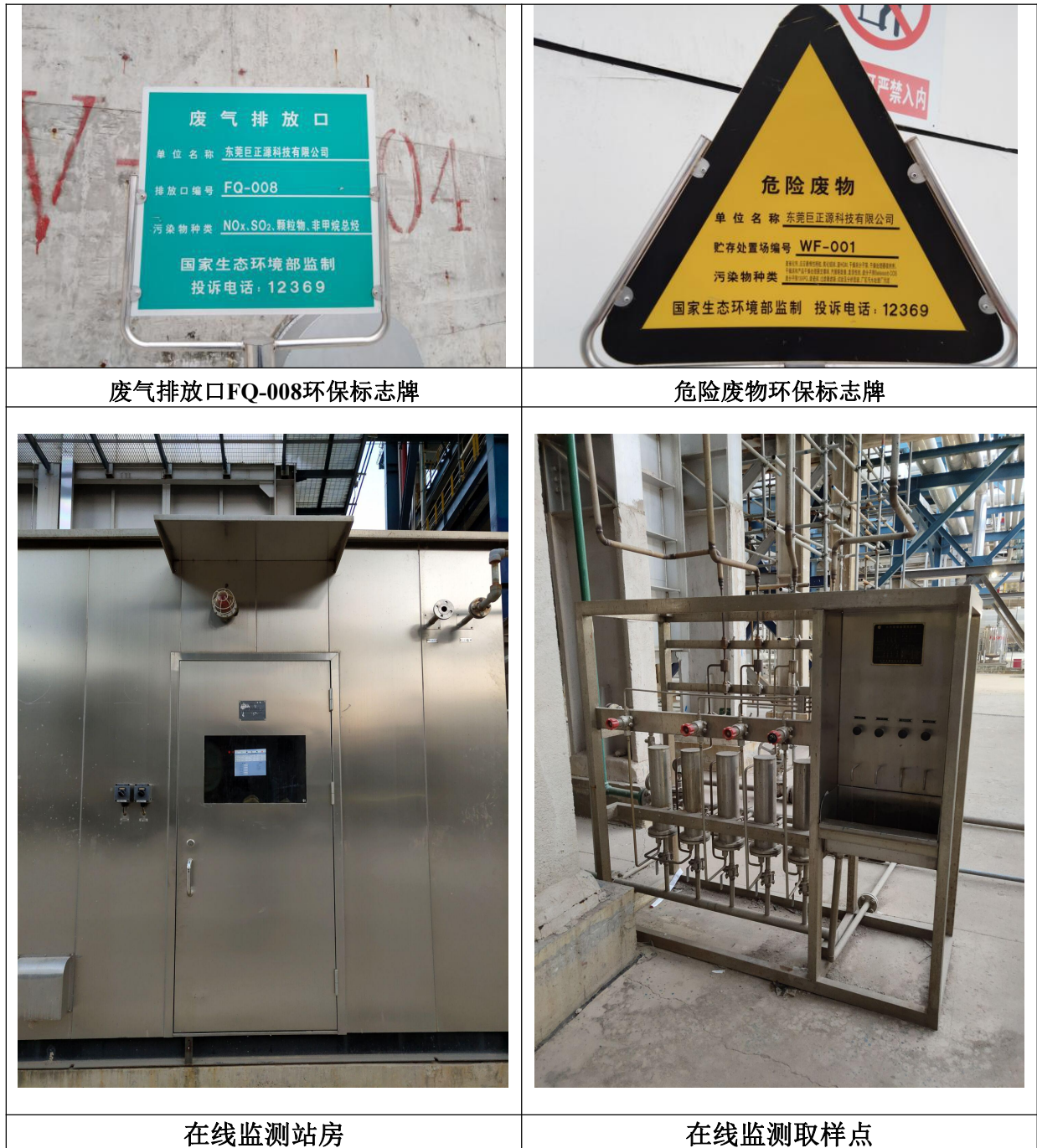
图4.2-2 一期工程及其配套项目部分环保标志牌及在线监测设备设置情况
