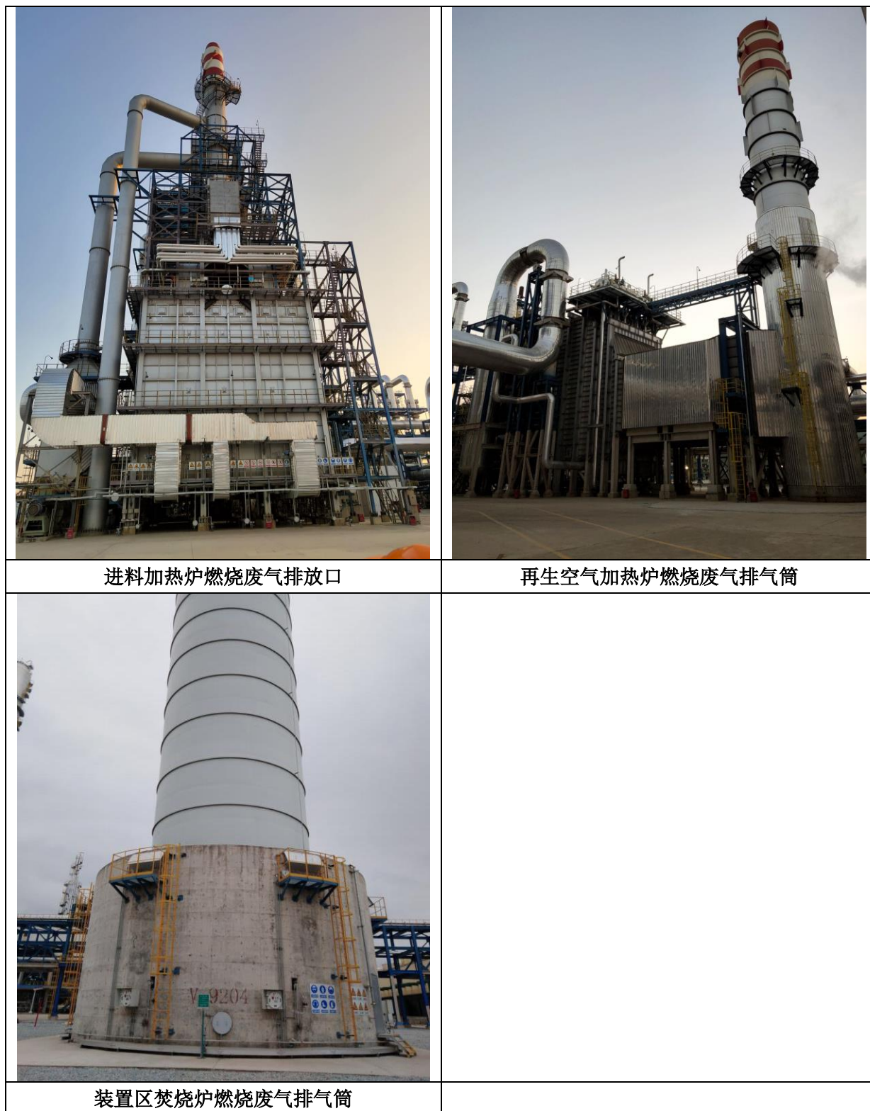
图 4.1-17 废气排气筒现场图
