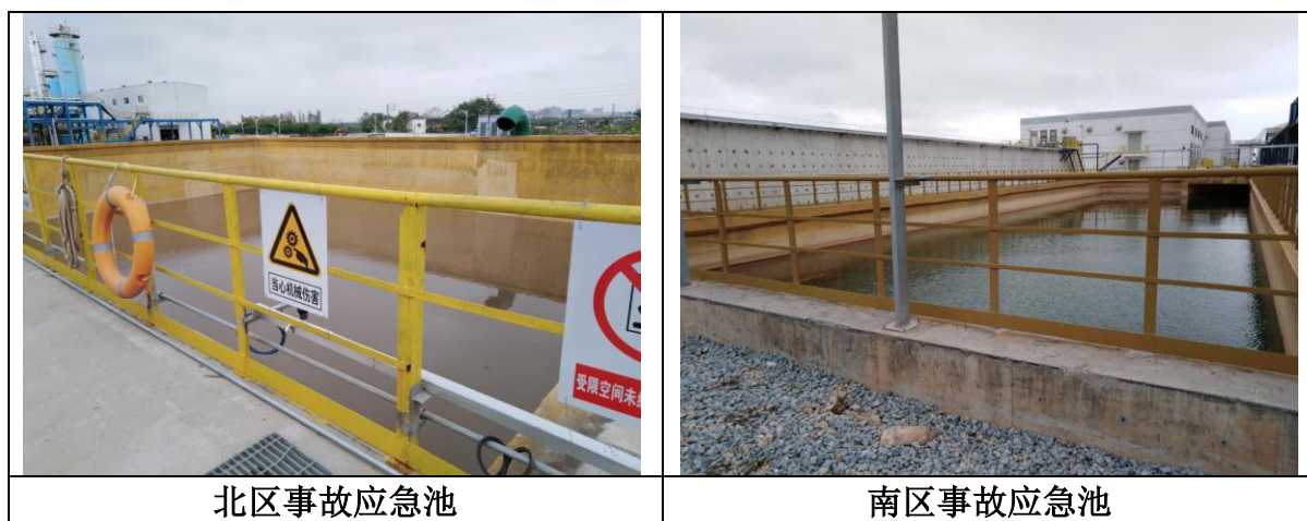
图 4.2-1 事故应急池照片
