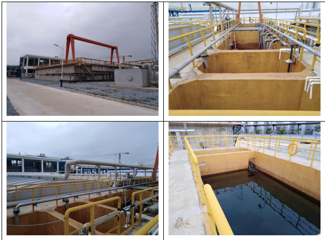
图 4.1-11 一期工程污水处理站现场照片
