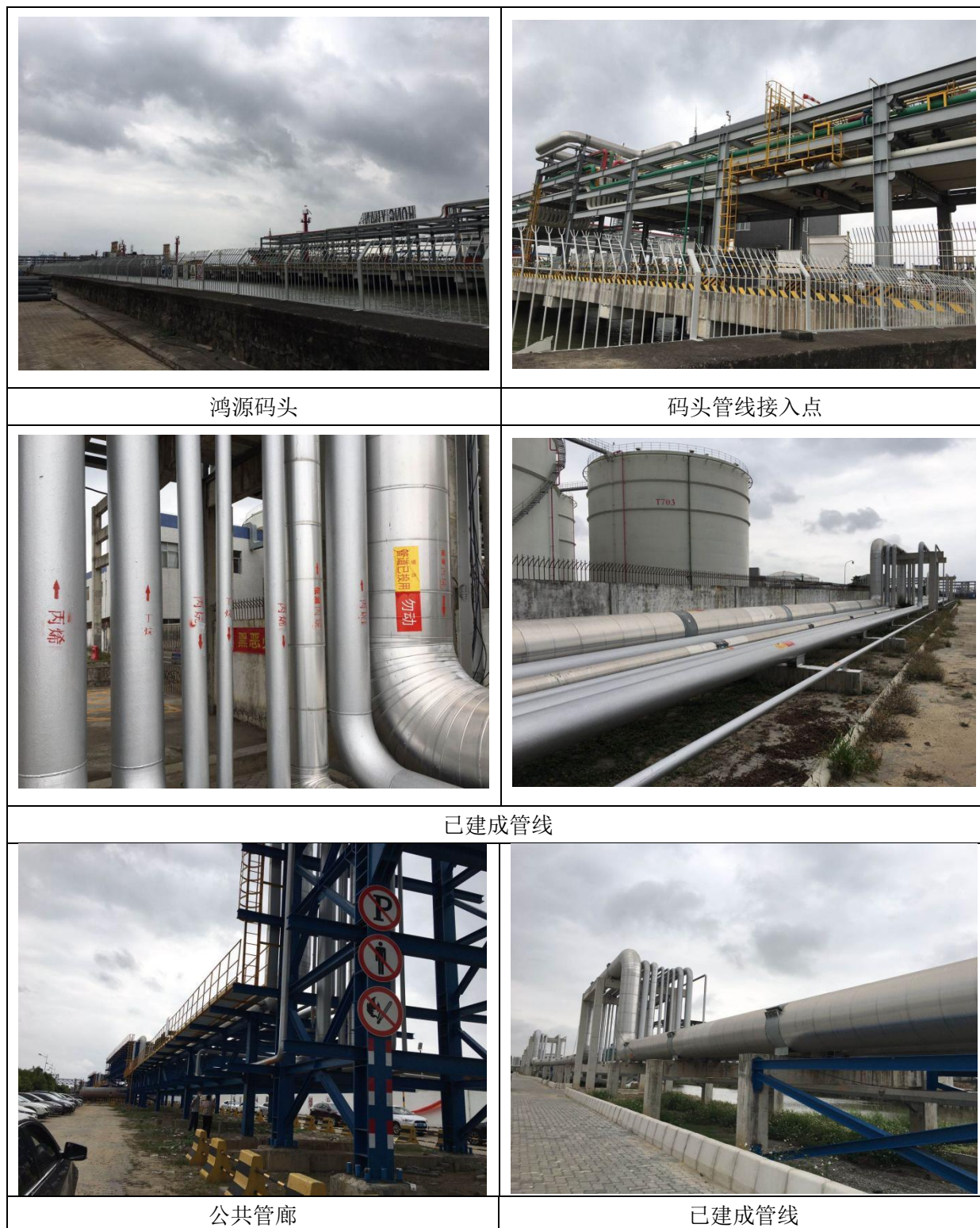
图 2.2-1 项目建成后的部分现场照片
