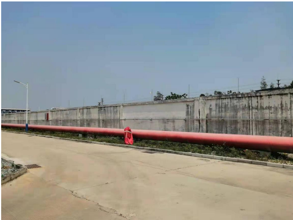
厂区围墙隔声措施
