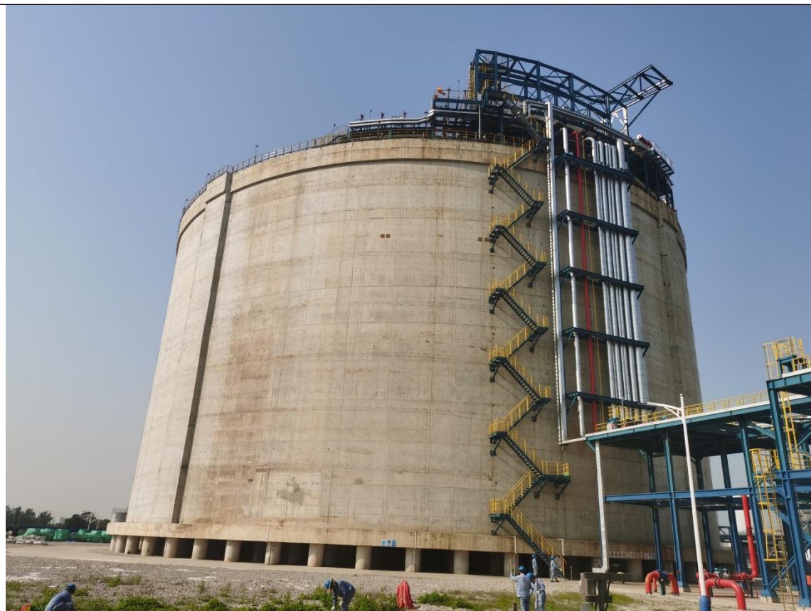
本项目低温丙烷罐
